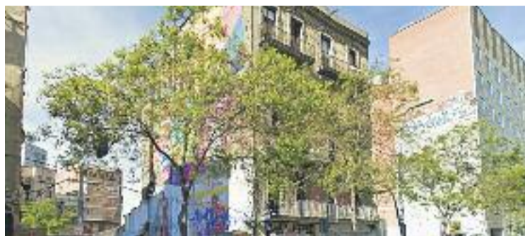
Al centre, l'edifici okupat que està pendent de ser enderrocat. Foto: Google Maps
