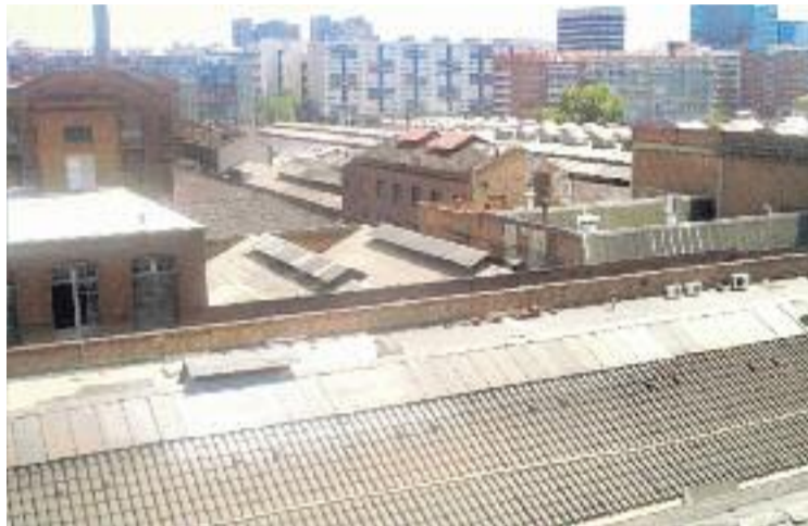
Després d'anys, la transformació de Can Batlló serà una realitat. Foto: Arxiu
