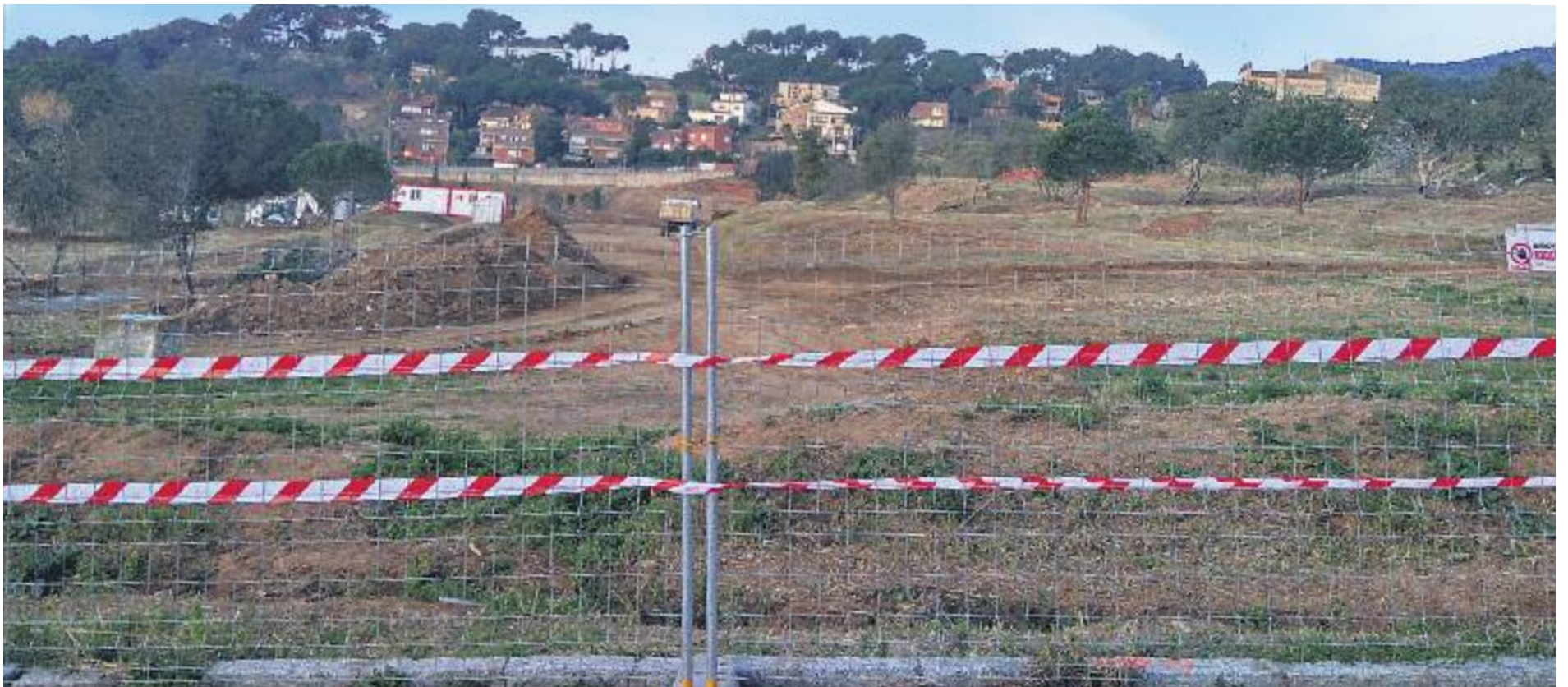
Les obres d'urbanització a la Cisa ja han començat. Foto: Línia Mar
