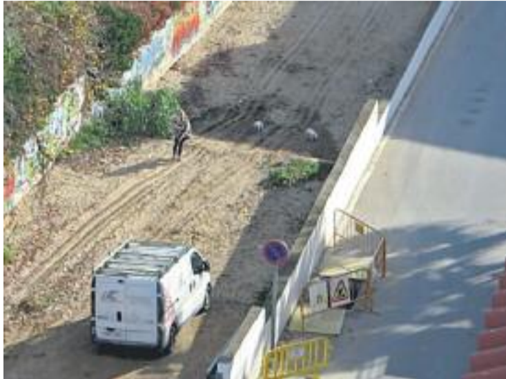
Ja han començat les obres de reforma. Foto: Ajuntament
