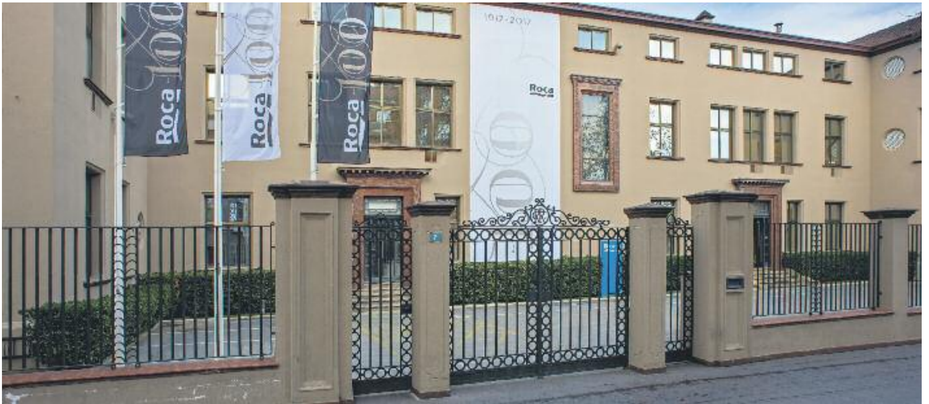
Les 32,6 hectàrees que ocupen les velles instal·lacions es reconvertiran en un nou barri. Foto: Roca
