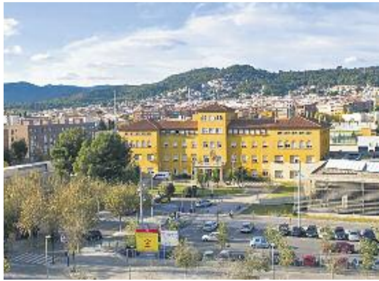
L'edifici d'urgències es prepararà per a la futura ampliació. Foto: ICS
