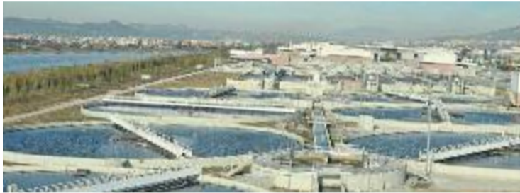
La depuradora del Prat, en el punt de mira. Foto: AMB
