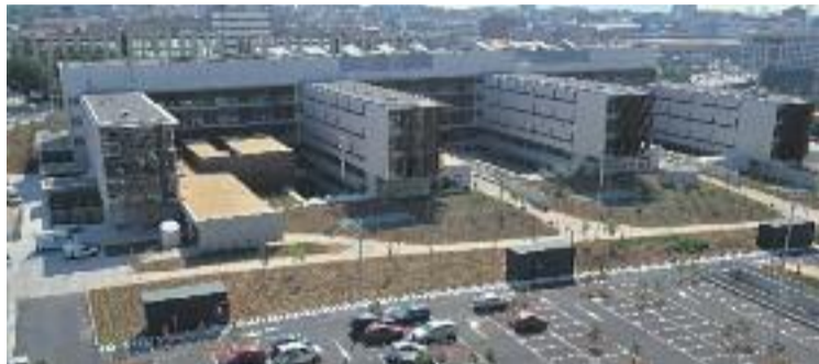
Vista aèria del Moisès Broggi. Foto: PEMB
