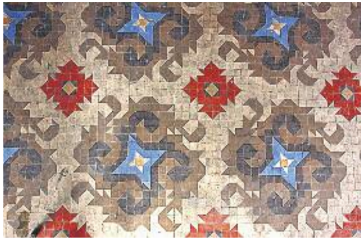
Part del paviment hidràulic de la Casa Burés, a Barcelona. Foto: Arxiu
