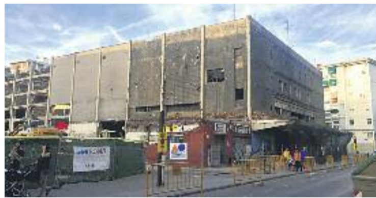
L'edifici dels cinemes va ser enderrocat a l'agost. Foto: Twitter (@Misifunski)
