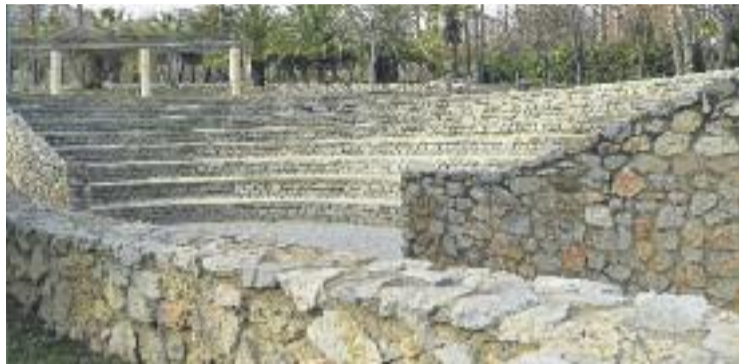
La construcció es faria darrere de l'edifici de servei. Foto: Cristian López
