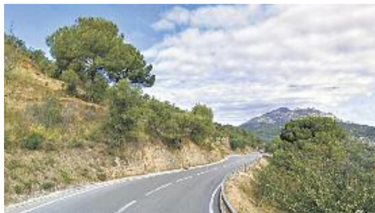
L'antiga carretera, un dels punts negres a Esparreguera. Foto: Google Maps
