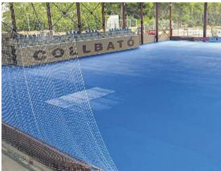
Les obres per renovar el ferm van acabar a finals d'agost. Foto: Ajuntament
