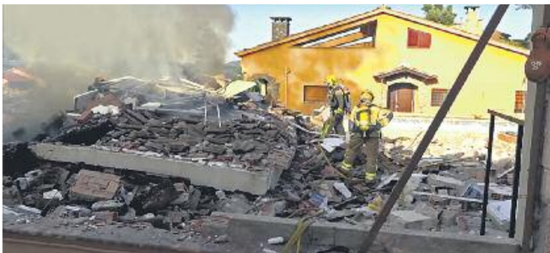
La casa es va esfondrar completament a causa de l'explosió. Foto: Bombers
