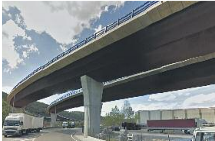
Les obres d'enllaç entre l'A2 i l'AP7 s'allarguen. Foto: Línia Nord
