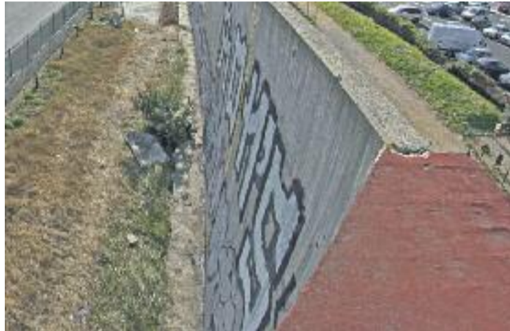
El mur funciona de pantalla acústica a l'autovia. Foto: Ajuntament
