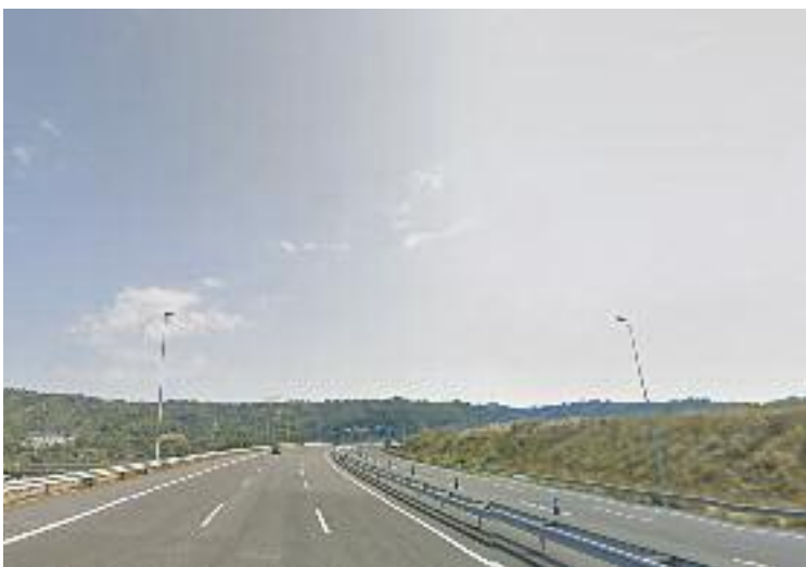
Tram de la B-40 entre Abrera i Olesa. Foto: Google Maps
