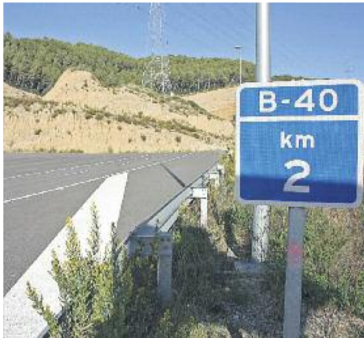
Les obres del Quart Cinturó estan aturades des del 2010. Foto: SCOT
