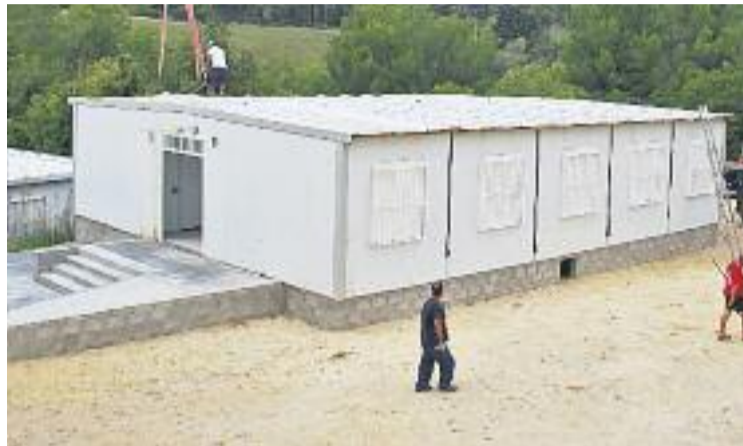
Un dels mòduls prefabricats instal·lats a l'institut. Foto: Ajuntament
