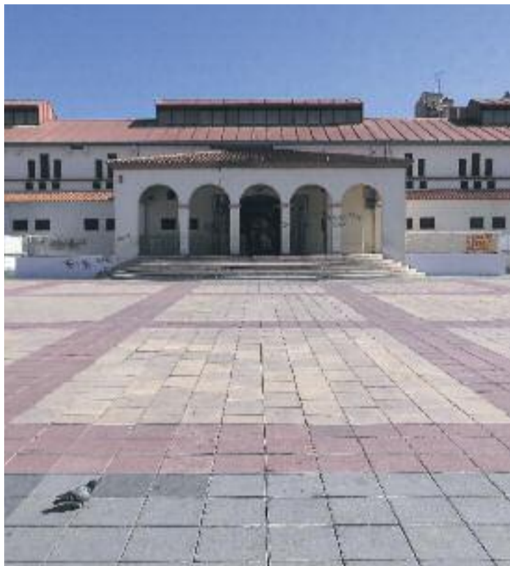
Edifici del Mercat Municipal d'Olesa. Foto: Arxiu
