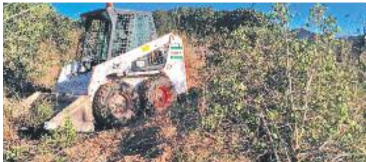
L'excavadora va arrencar arbres i matolls. Foto: Salvem el Turó de l'Enric
