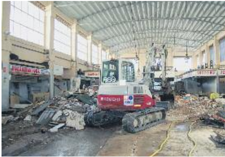
Algunes parts de l'interior es van començar a enderrocar el 2015. Foto: Arxiu
