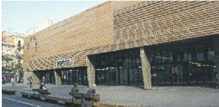
El nou edifici té 10.000 metres quadrats. Foto: Línia Nord
