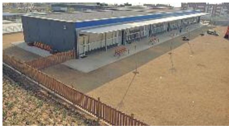
L'Escola Marina serà la primera que obrirà les seves portes. Foto: EM
