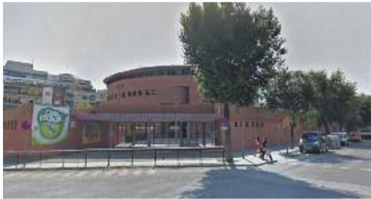
L'escola necessita obres d'arranjament a la façana. Foto: Google Maps
