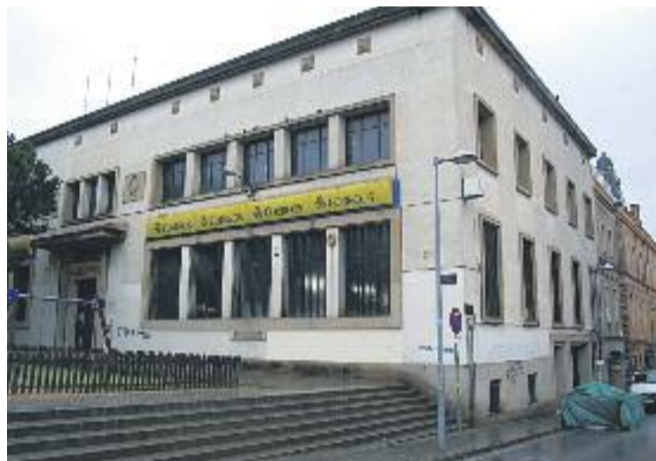
L'edifici de Correus va ser construït als anys 50 del segle XX. Foto: Ajuntament
