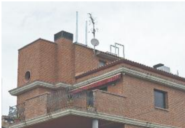
Antena de Vodafone al carrer Renaixement. Foto: Línia Vallès
