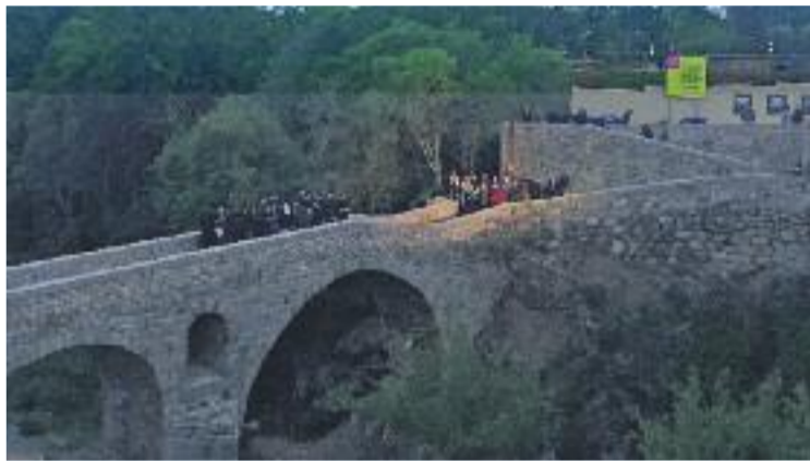
Inauguració de la restauració del pont romànic. Foto: Ajuntament de Caldes
