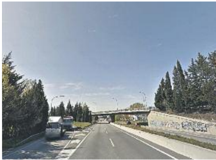
Tram de la C-17 on es faran les obres. Foto: Generalitat de Catalunya
