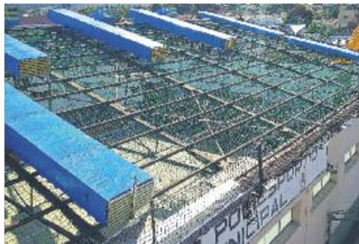
Substitució del sostre d'uralita. Foto: Ajuntament de Sant Fost
