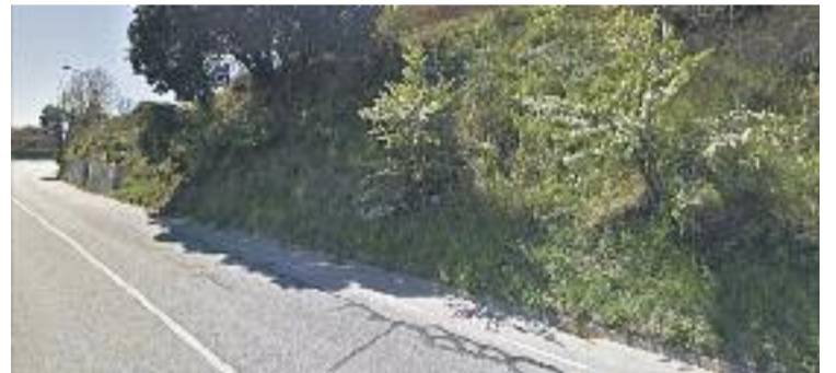
Les obres de l'avinguda Catalunya ja han començat. Foto: Google Maps
