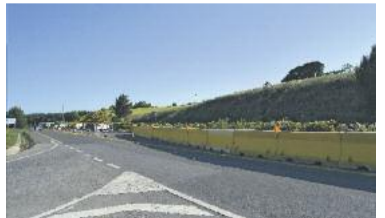
Obres de la rotonda a la ronda dels Pinetons. Foto: Línia Vallès
