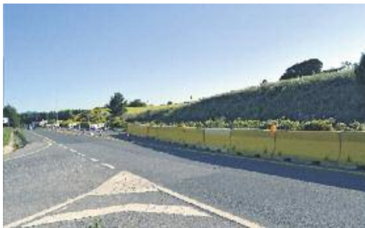
Obres de la rotonda a la ronda dels Pinetons. Foto: Línia Vallès
