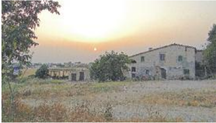
Actualment, la masia de Can Serra està molt deteriorada. Foto: Arxiu
