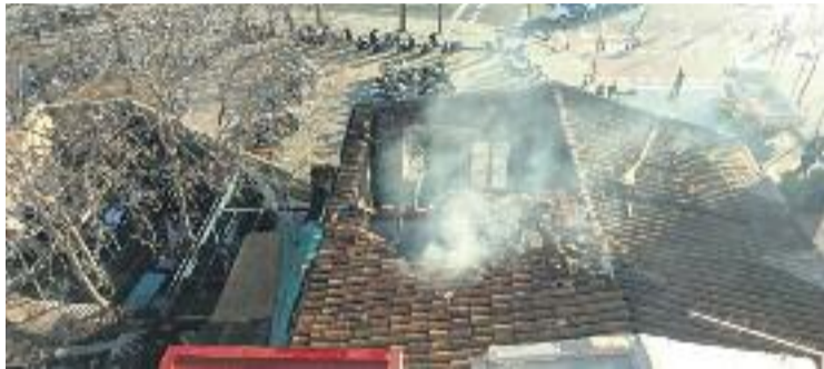
L'edifici va quedar en molt mal estat per l'incendi. Foto: Twitter (@arran_sarria)
