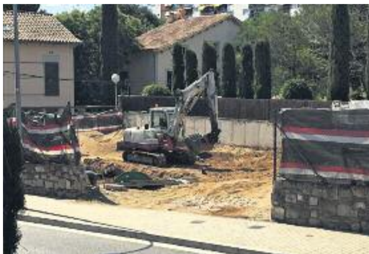
Les obres de la benzinera ja estan en marxa. Foto: Línia Sarrià
