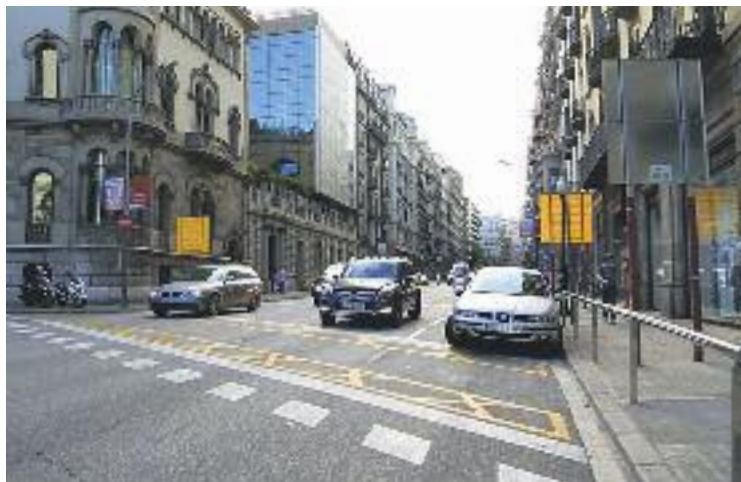
Les obres permetran millorar la circulació dels vehicles. Foto: Ajuntament
