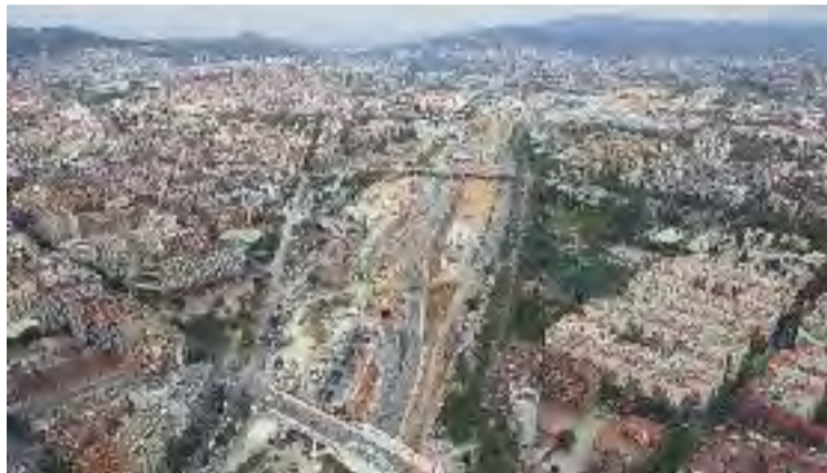
Imatge aèria de les obres de l'estació de la Sagrera. Foto: Arxiu
