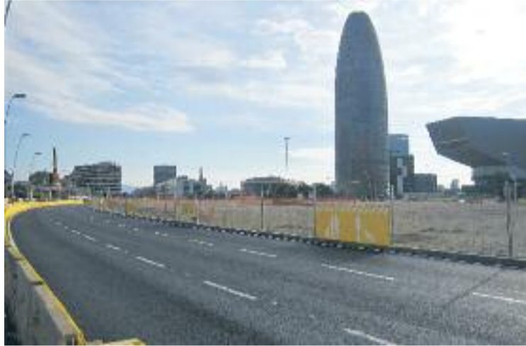
Imatge de la calçada amb tres carrils. Foto: Línia Sant Martí
