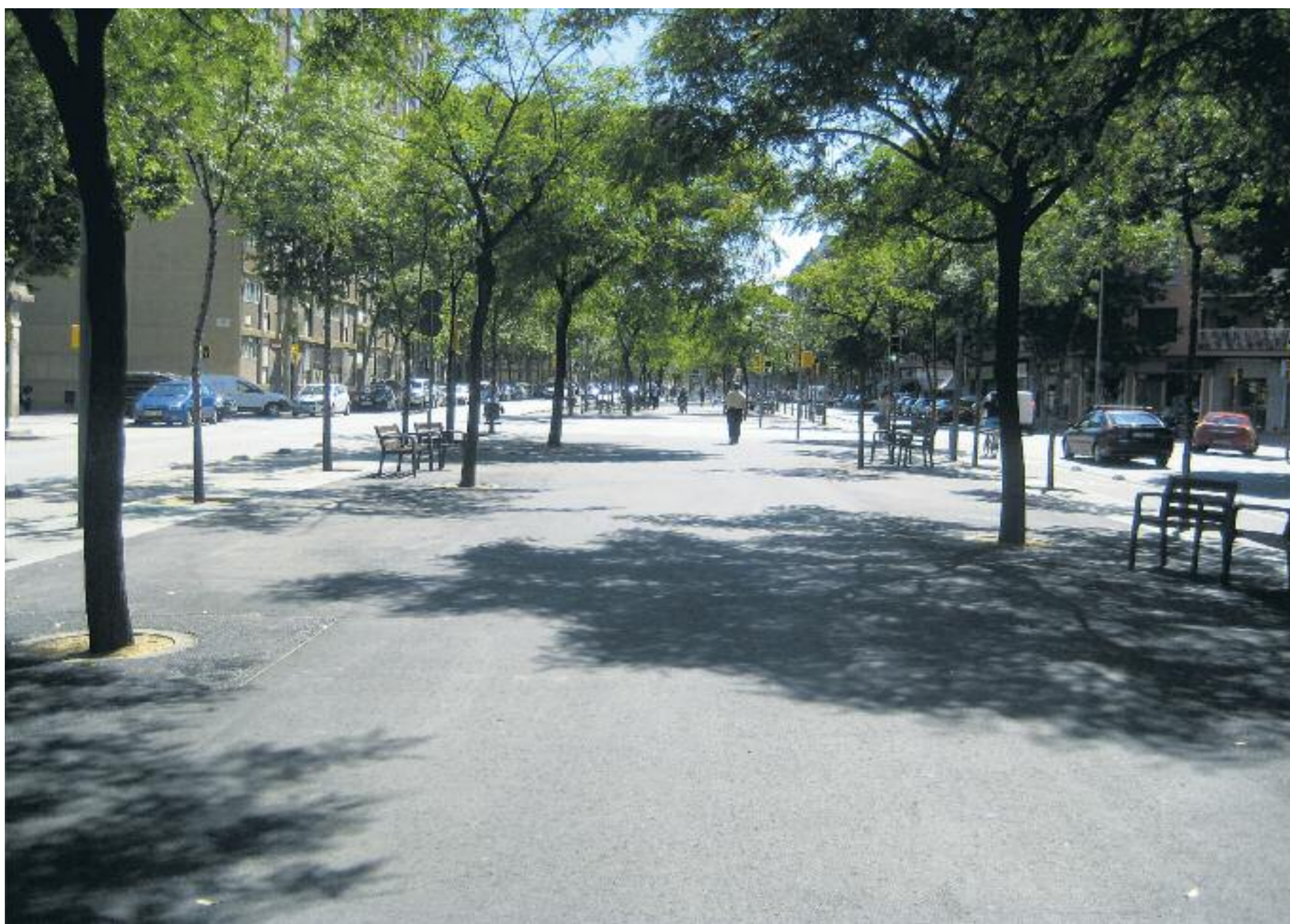
Aspecte actual de la rambla de Guipúscoa, un cop enllestides algunes de les millores. Foto: Districte
