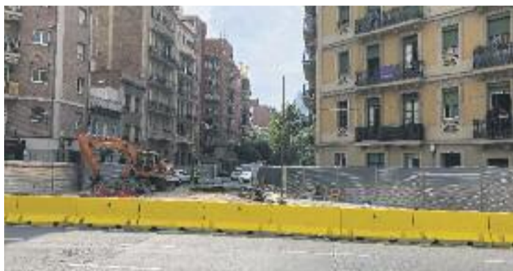
Les obres estan provocant pèrdues als comerciants. Foto: Línia Sant Martí
