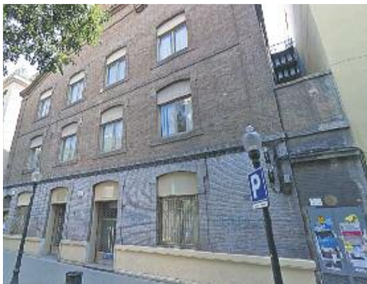
L'edifici d'Hisenda passarà a mans municipals. Foto: Google Maps
