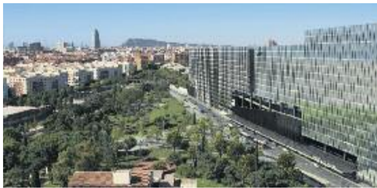
Està previst que les obres de l'estació acabin l'any 2019. Foto: BSAV
