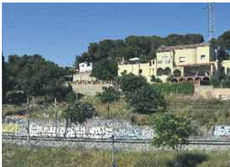
Les obres de soterrament començaran a principis del 2020. Foto: Cristian López
