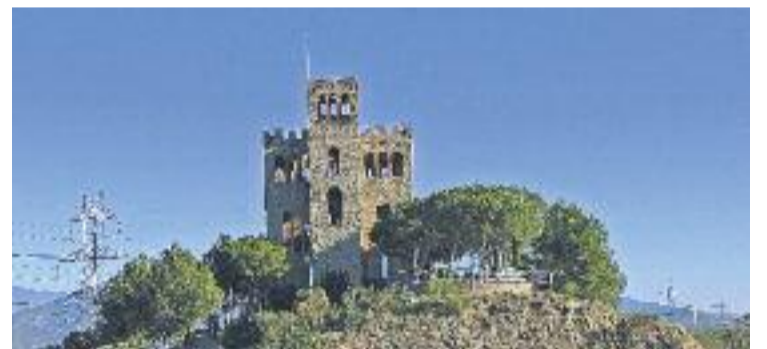
El Castell de Torre Baró va ser construït el 1905. Foto: Districte
