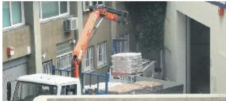
Les obres van començar a principis de mes. Foto: Twitter (@assocvml)
