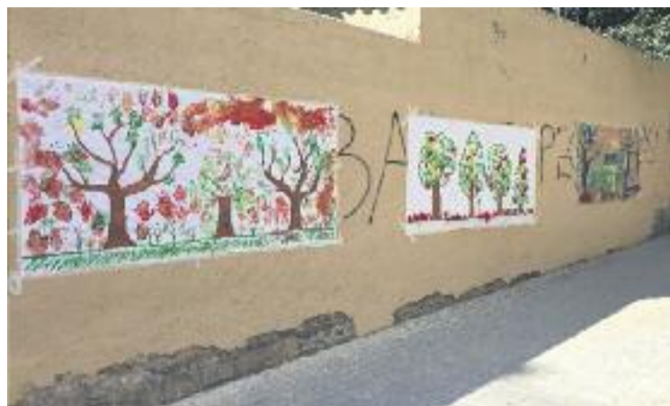
Imatge d'una façana del solar on es farà la residència d'avis. Foto: Arxiu
