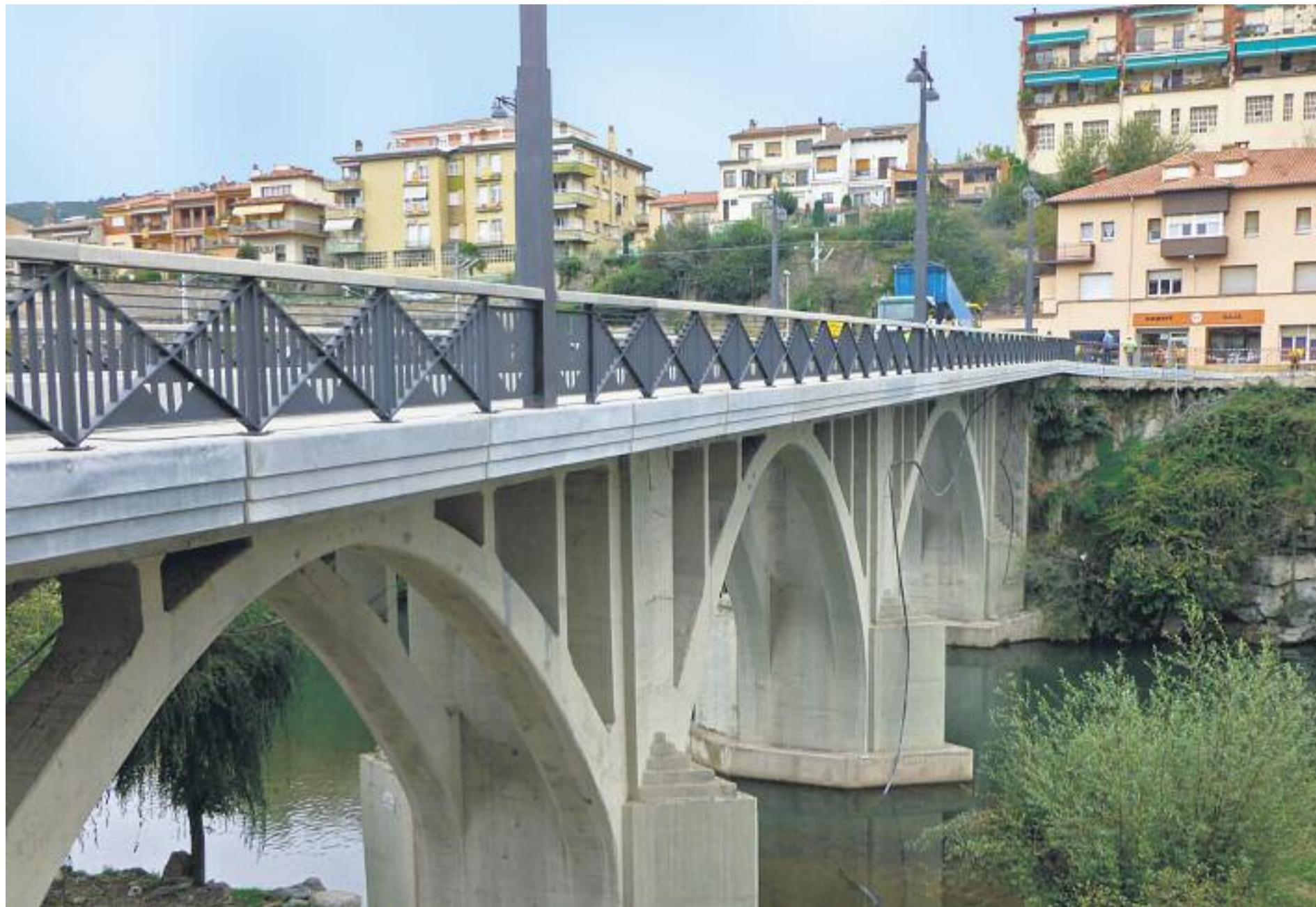
Durant l'anterior mandat, la Diputació va impulsar la reforma del pont de Sant Quirze de Besora, sobre el riu Ter. Foto: Diputació de Barcelona
