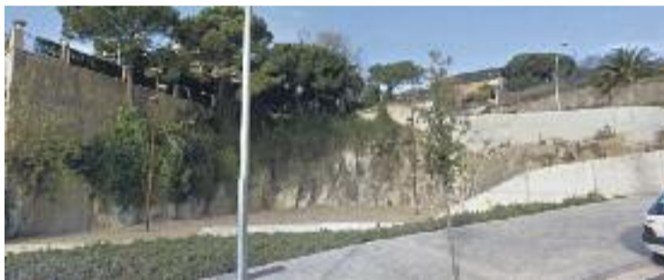
El solar on es construeix el nou edifici de la Betània-Patmos. Foto: Arxiu
