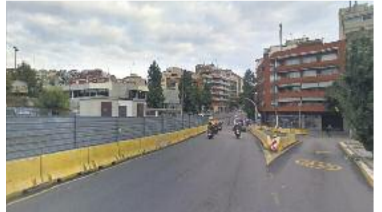
Les obres començaran a partir del mes de setembre. Foto: Google Maps
