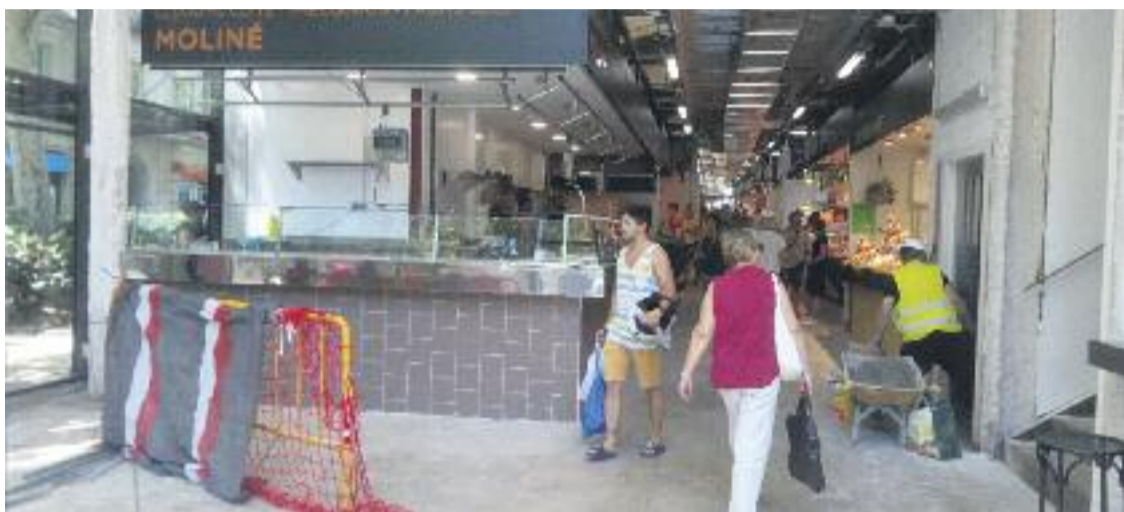
Imatge de clients del mercat entre els obrers, que continuen treballant per acabar els últims detalls. Foto: Línia Gràcia
