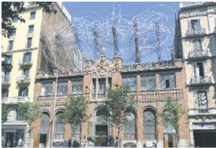
La façana de la Fundació Tàpies, al carrer Aragó. Foto: Pierrot Heritier
